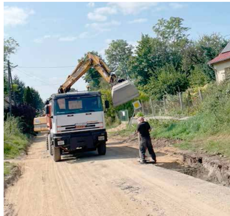
Na zdjęciu prace na drodze w Przytoni
