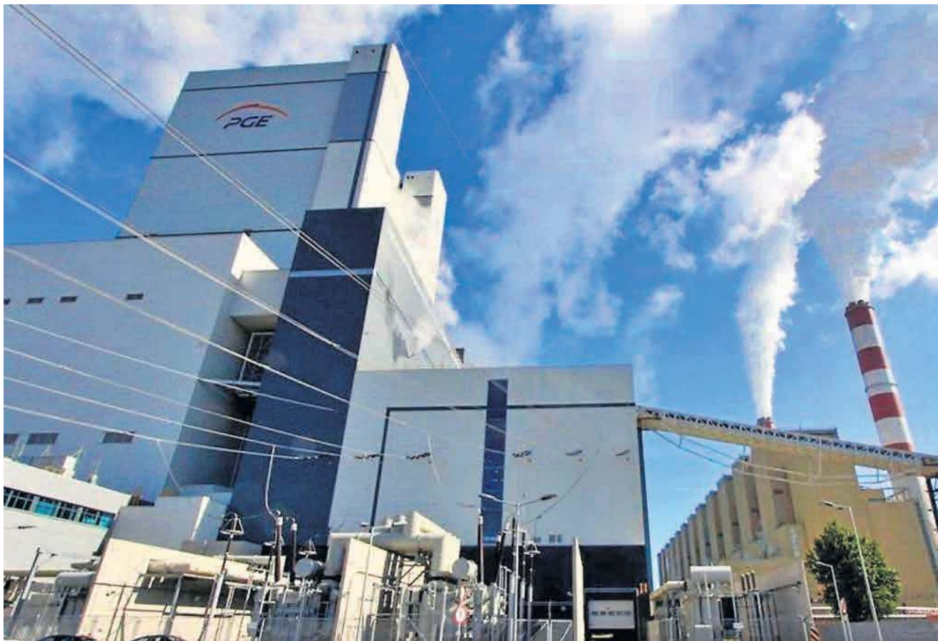
Pierwszy prąd z Bełchatowa popłynął 39 lat temu. Najnowsza część elektrowni – blok 858 MW – ma 9 lat
