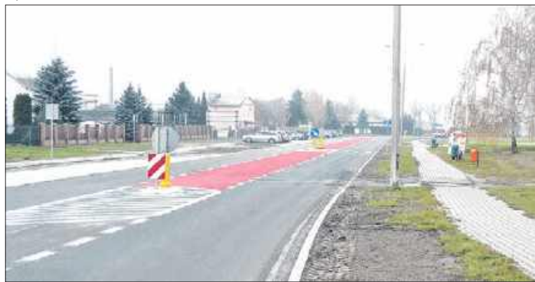
15 listopada zakończono prace remontowe na alei Jana Pawła II. Sfinansowali je miasto i Starostwo
