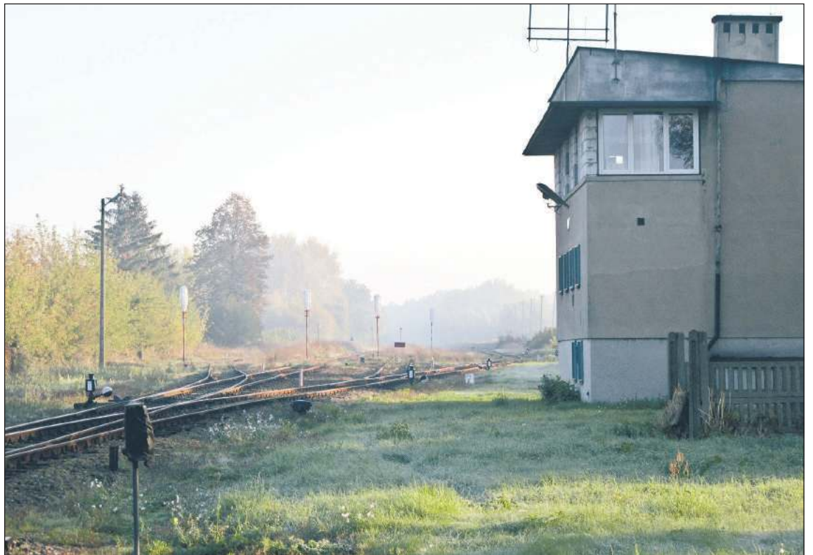
Stacja w Brzeźnicy również doczeka się remontu, a wraz z nią także jeden z ważniejszych węzłów na linii.
