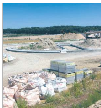
Tak wygląda budowa ekspresówki pod Komarowem-Osadą.
