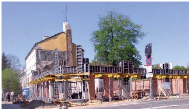
Do góry pną się mury nowego budynku usług kulturalnych przy ul. Krótkiej nr 1, koszt tego obiektu ma wynieść 4,38 mln zł
