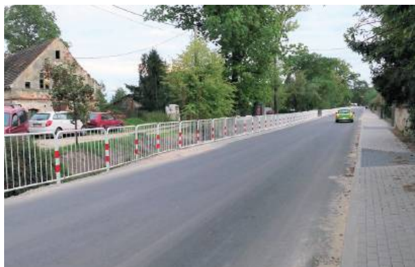
Droga powiatowa w Gościęcicach po przebudowie
