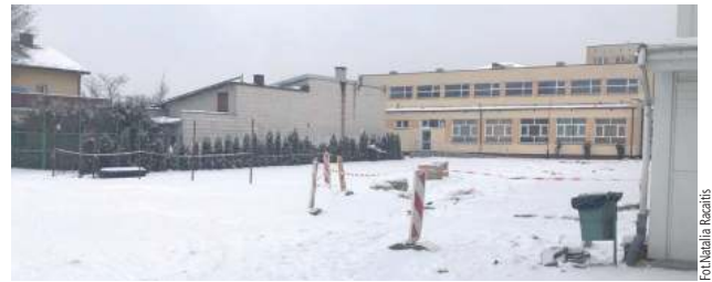
Aktualnie przy SP nr 3 w Biłgoraju wykonywane są roboty związane z kanalizacją deszczową i siecią energetyczną
