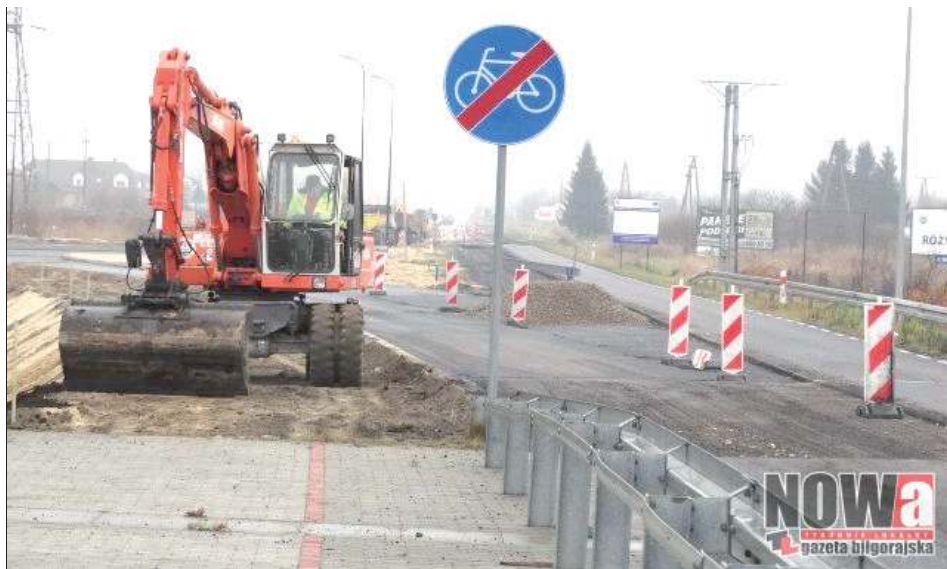
Droga Księżpol-Harasiuki idzie do remontu
