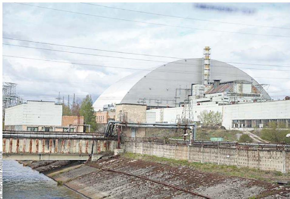
Kopuła nad zniszczonym czwartym blokiem energetycznym Czarnobylskiej Elektrowni Jądrowej
