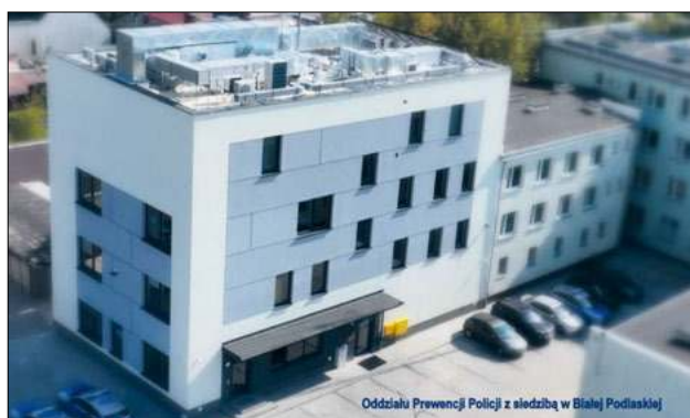
Wykonawcą rozbudowy bialskiej komendy było Przedsiębiorstwo Wielobranżowe Budomex Sp. z o.o. z siedzibą w Białej Podlaskiej. Zadanie inwestycyjne zaplanowano w formule „zaprojektuj i wybuduj”
