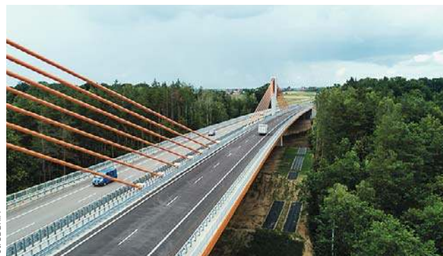
Odcinek drogi ekspresowej S5 Ornowo - Wirwajdy będzie kontynuacją obwodnicy Ostródy w ciągu drogi krajowej nr 16
