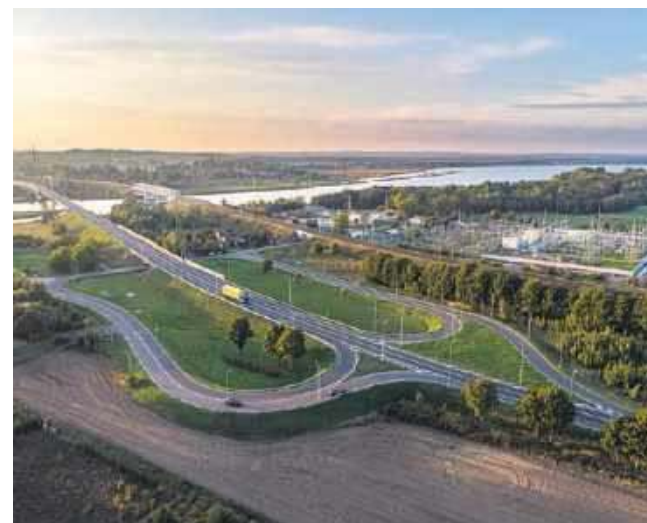
Rozbudowana stacja elektroenergetyczna Reclaw.
