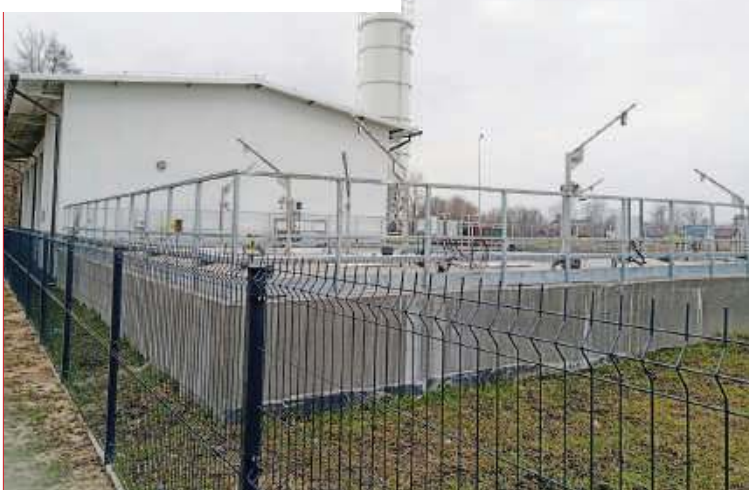
Nowe obiekty Gminnej Oczyszczalni Ścieków w Księżpolu
