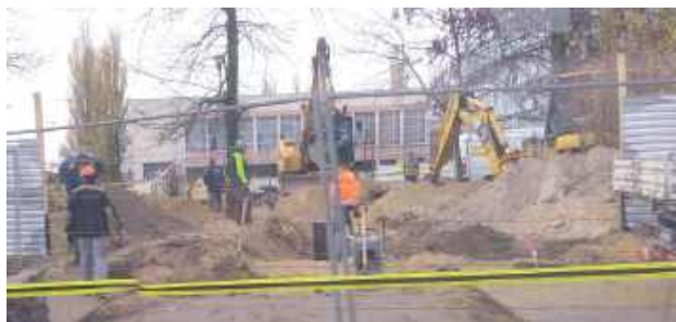
W piątek prace na budowie nowego gmachu starostwa ruszyły z kopyta
