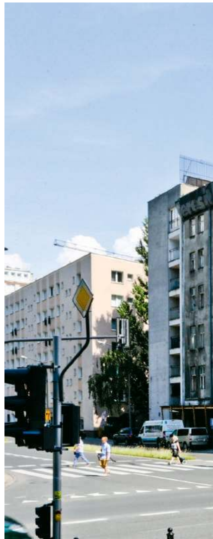
Kamienica przy ul. Złotej 83 w rusztowaniach | fot. T.
