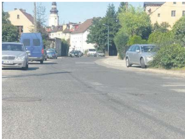
Wartość remontu ul. Brzegowej w Strzelinie to ok. 1,9 mln złotych
