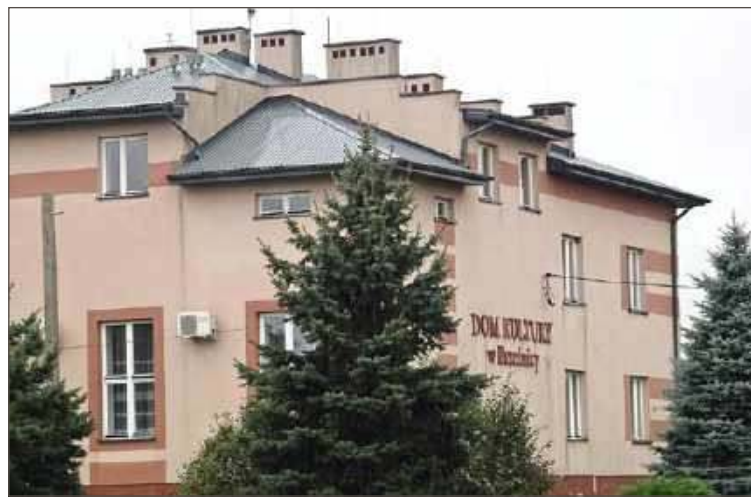
Tablice znajdowały się na tym budynku w Brzeżnicy.
