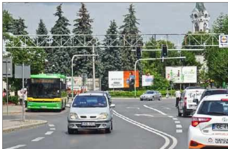
To jedno ze skrzyżowań, które znalazły się na liście do przebudowy.
