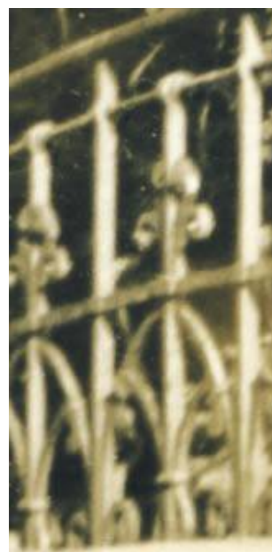
Wycinek kształtu balustrad ze zdjęcia z 1952 roku
