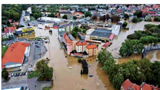
W niedzielę wschodnia część Prudnika została zalana wodą
