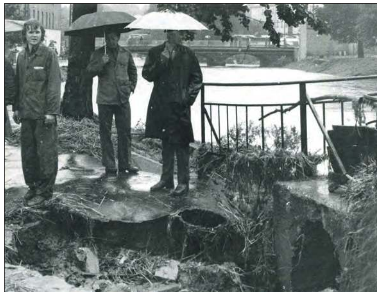
Dojście do kładki obok ul. Kochanowskiego w Prudniku. Asfalt na sąsiednim chodniku pofałdował się, niczym gumowa okładzina. (1997)
