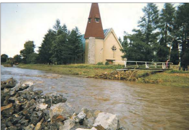
Wysoka woda niszczy kładki na Złotym Potoku (1997)
