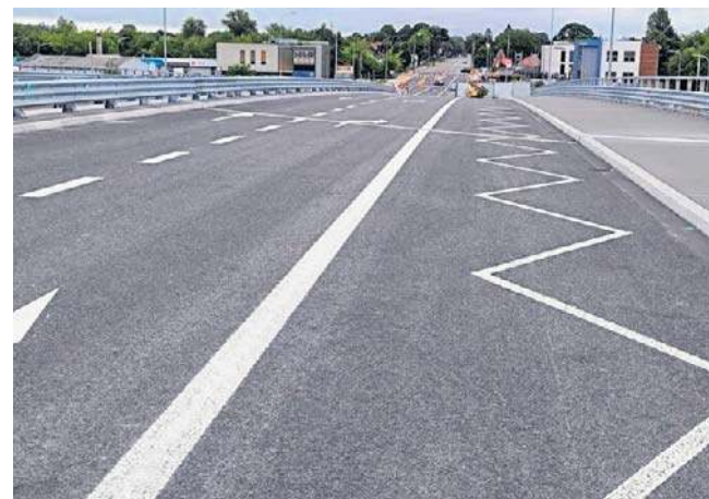
Czerwiec. Otwarty został wiadukt i przystanek kolejowy Radom Wschodni. To ważna inwestycja
