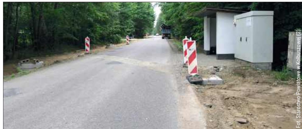
Na trasie Cmolas-Świerczów powstaje nowa, bezpieczna droga z gładką nawierzchnią i ścieżką pieszo-rowerową. Ciężki sprzęt już pracuje jest już na miejscu. Realizacja tej inwestycji pochłonie 8 mln zł
