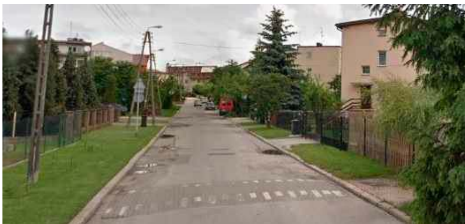
Przed ubiegłorocznym remontem na ulicy Radość były progi zwalniające, ale po jego zakończeniu nie wróciły na swoje miejsce, bo takie było życzenie mieszkańców
