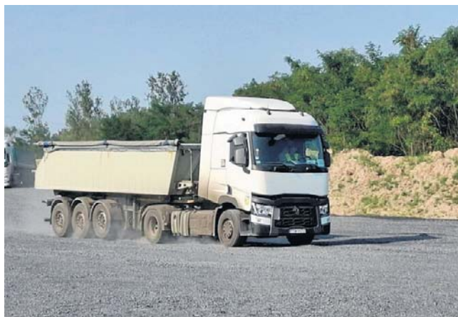
W oczekiwaniu na ostateczne decyzje na zaplecze budowy są zwożone materiały budowlane
