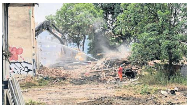
Polewanie rozbieranych ścian wodą niewiele daje
