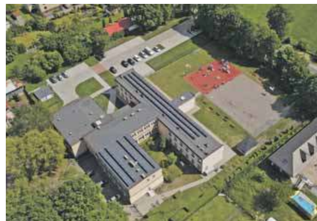
Na ograniczenie niskiej emisji mają wpływ odnawialne źródła energii. W Świerkłańcu takie instalacje można zobaczyć na dachach budynków użyteczności publicznej: szkoły czy znajdującego się w sąsiedztwie urzędu gminy
