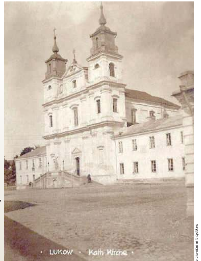
Zdjęcie wykonane w czasie I wojny światowej, najprawdopodobniej przez żołnierza niemieckiego. Kościół pw. Przemienienia Pańskiego, a zwłaszcza jego plebania były w trakcie przygotowań do Powstania Styczniowego głównym miejscem odbywania narad spiskowców. Oprócz księży Słotwińskiego i Brzóska w naradach brał udział rektor konwiku Chrepiński i pozostali wikariusze Kożuchowski i Wydzga
