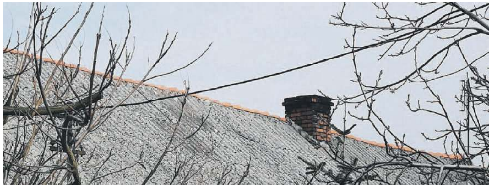
Dach kryty eternitem
