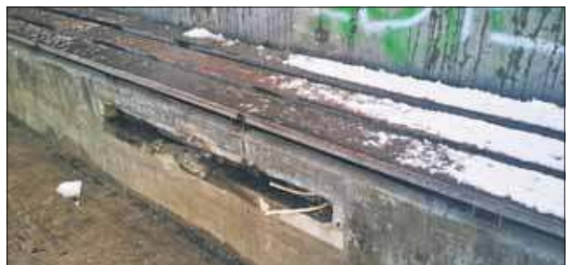
Wandale wyrwali 26 lamp
