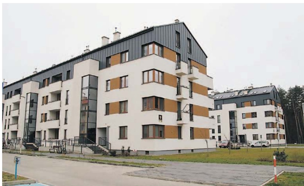
Dwa bloki przy ulicy Orzeszkowej mają już swoich lokatorów. Budowa trzeciego bloku ma ruszyć w drugiej połowie tego roku
