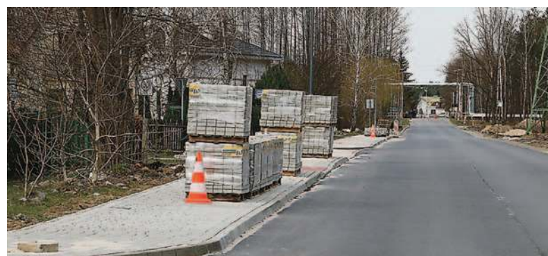
Również na wiosnę odświeżane jest osiedle Hutnik. Nowe chodniki powstają między innymi na ulicy Sosnowej
