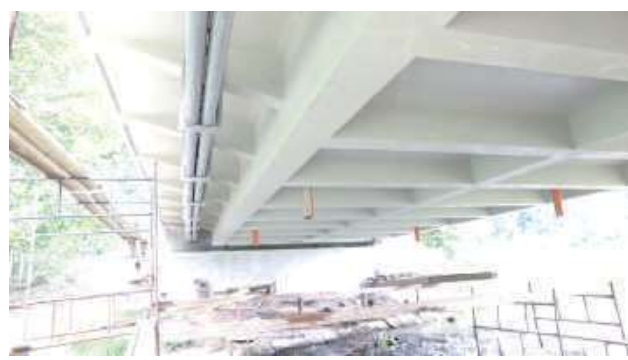
Od maja most jest zamknięty i przechodzi kompleksowy i gruntowny remont
