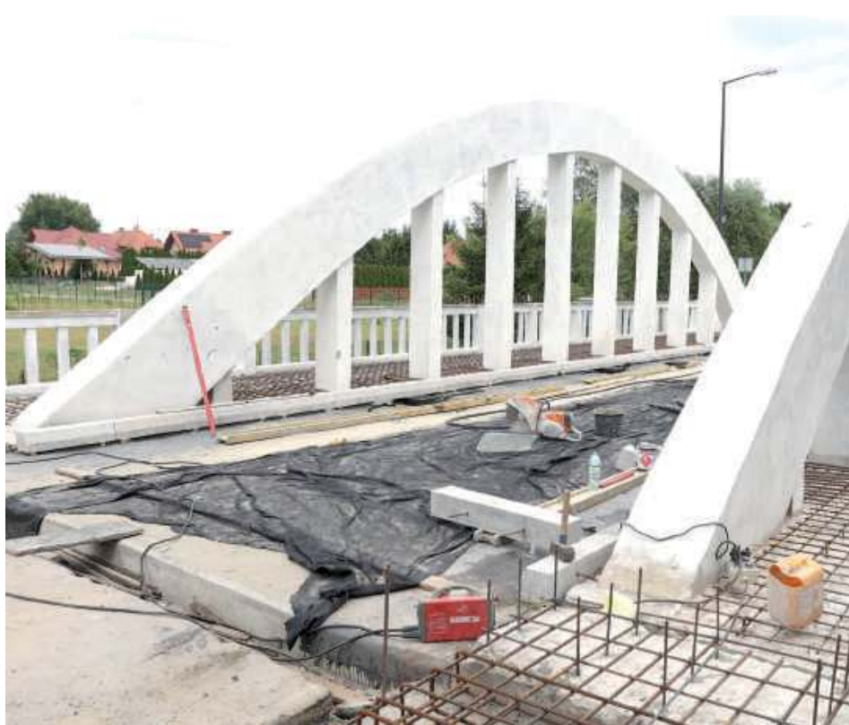
- Remont mostu przy ul. Lubelskiej w Biłgoraju przebiega zgodnie z planem - zapewnia Starostwo Powiatowe
