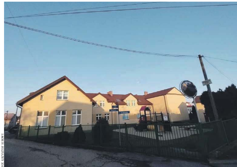
Budynek Szkoły Podstawowej w Ostrężnicy
