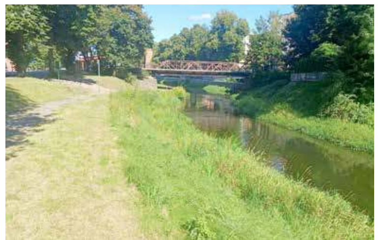
Nieskosiwana trawa jest widoczna nieopodal mostu
