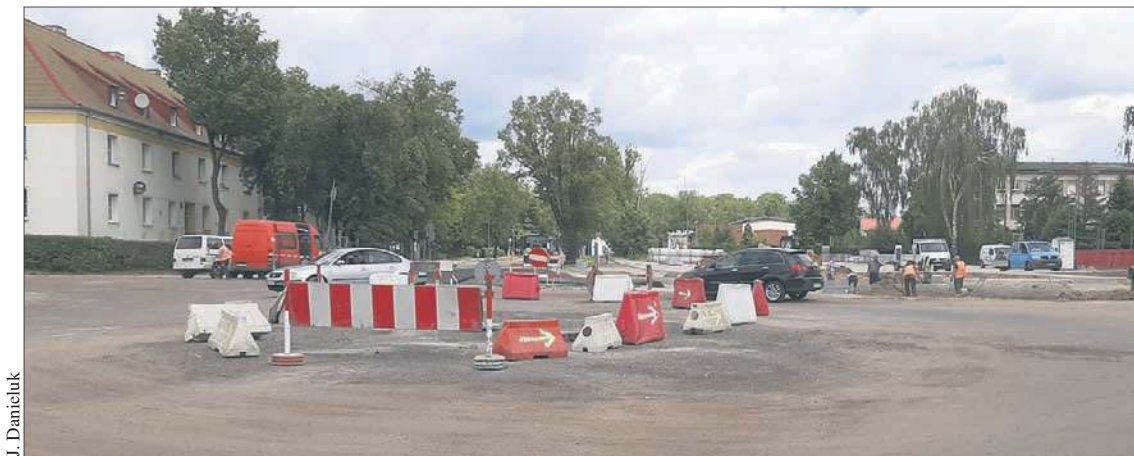
Trwa budowa ronda na skrzyżowaniu al. Kilińskiego z ul. Mostową, Warszawską i Norbertańską
