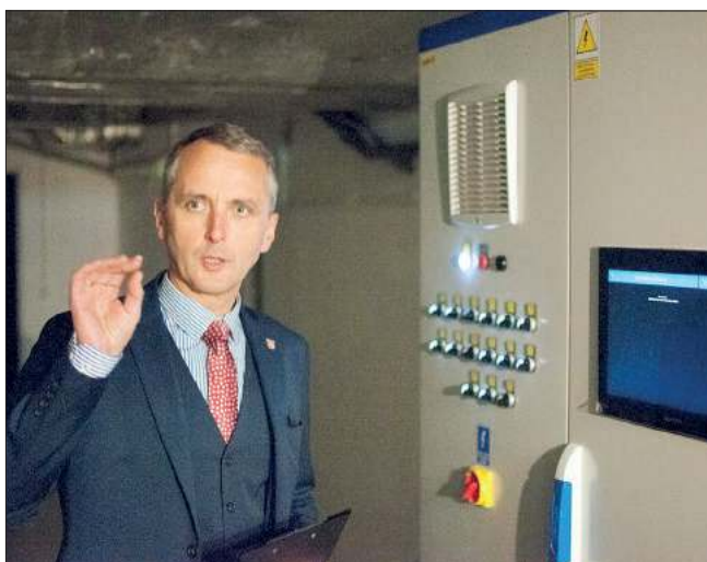
Kryta pływalnia H 2 Ostróg w Raciborzu przeszła gruntowny remont instalacji uzdatniania wody. Teraz woda jest czysta i pozbawiona bakterii, jednak klientów brakuje. – Mamy około 70 – 80% klienteli w porównaniu do czasu sprzed pandemii – mówi Nowinom Dariusz Polowy. Na zdjęciu obok stacji sterowniczej instalacji uzdatniania wody.
