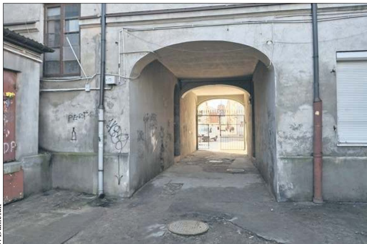
„Żelazna brama” przy ul. Kwiatka
