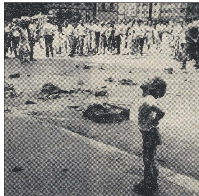
Miejsce tragicznego wypadku na Placu Kościuszki. Widoczne odłamki zdobionej attyki rozstraskanego o bruk
