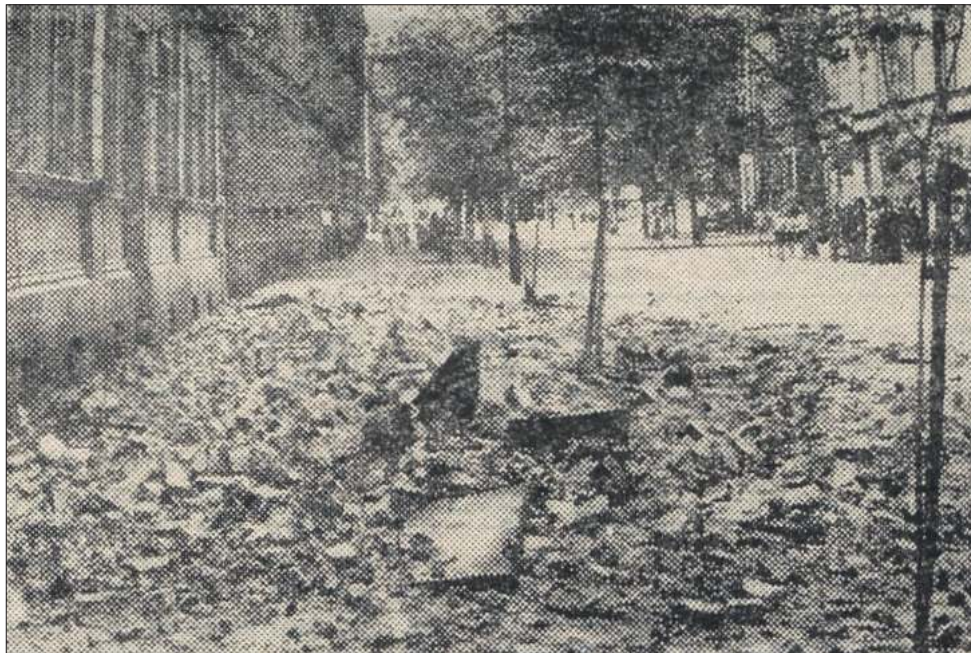
Ulice miasta zasypane były cegłami z gzymsów i kominów, dachówkami i kawałkami poszycia dachów
