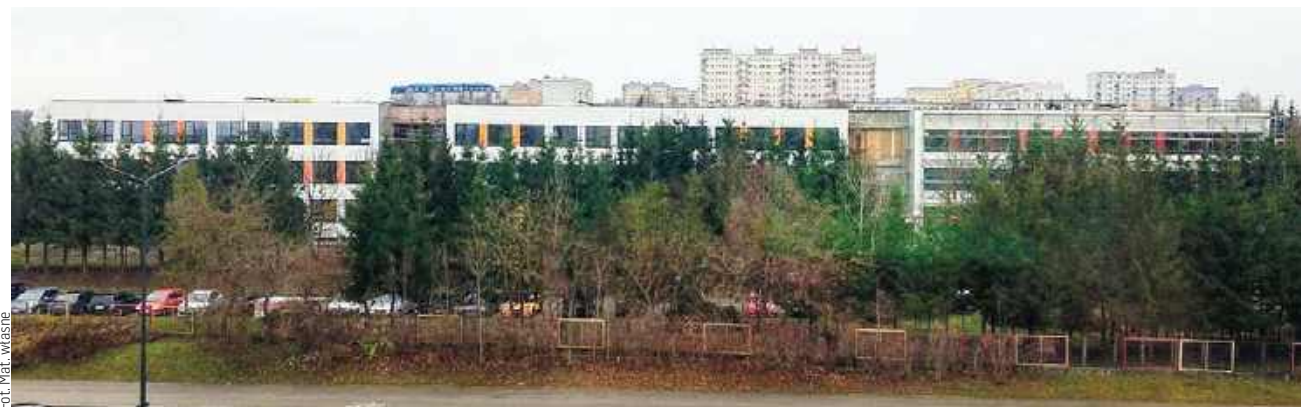
ZSO nr 3 przy ul. Wańkowicza w Olsztynie przechodzi termomodernizację
