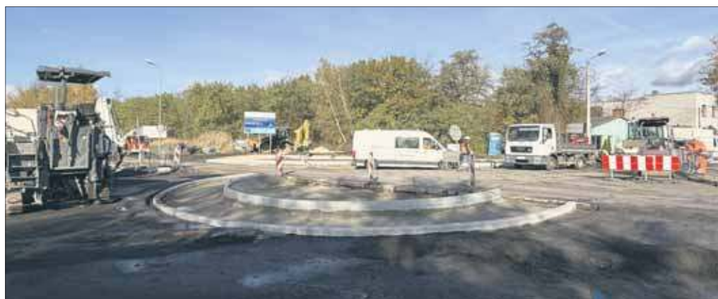
Budowa ronda na DK 79 w Jaworznie
