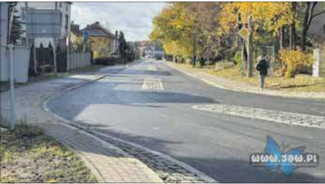
Ulica Jaworznicka po remoncie. Droga została otwarta
