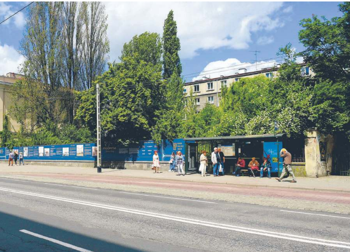
Obok budynku Banku Polskiego powstanie obiekt usługowo-mieszkalny | fot. Fotomag/Gazeta Polska
