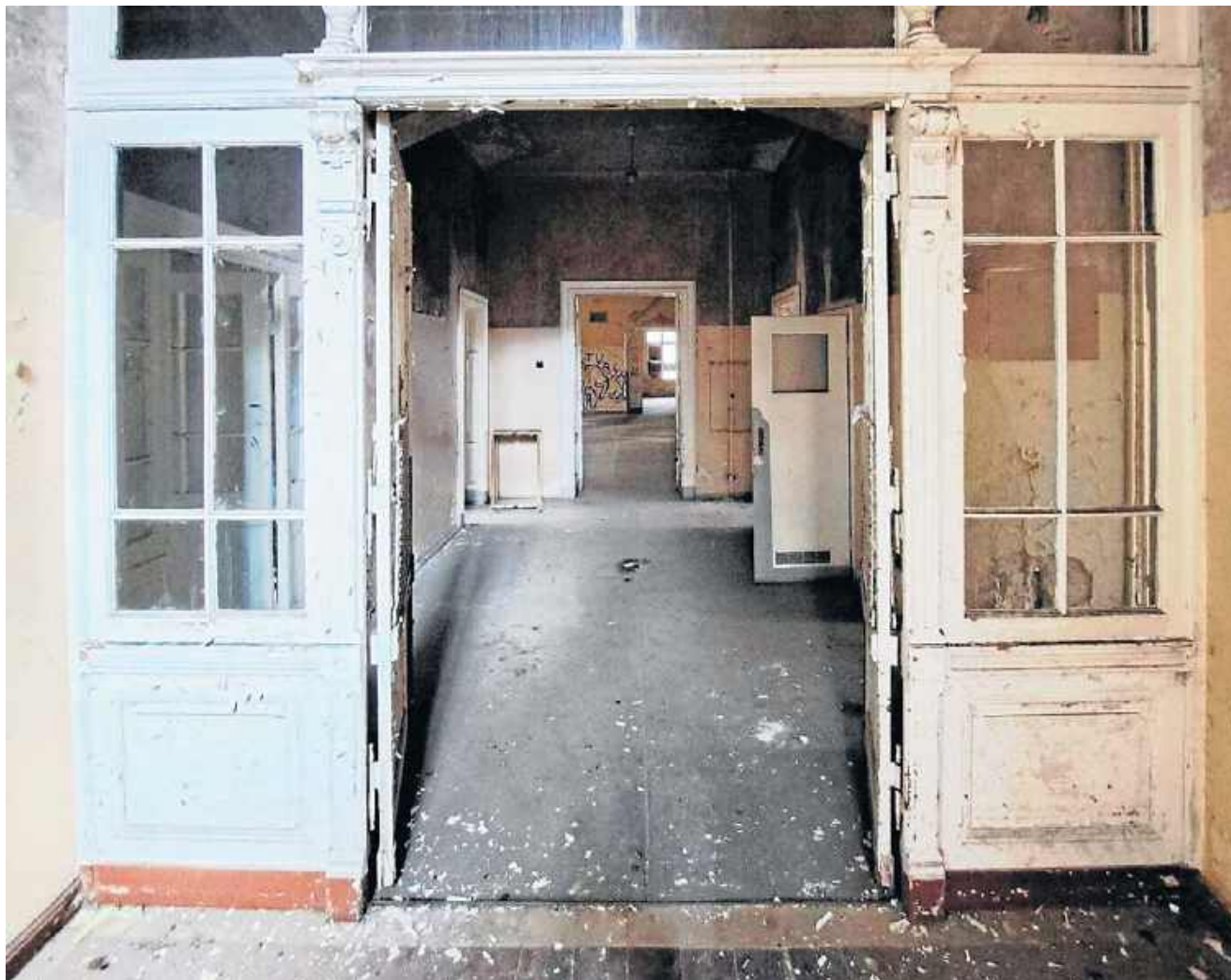
Tak wyglądał budynek przed remontem
