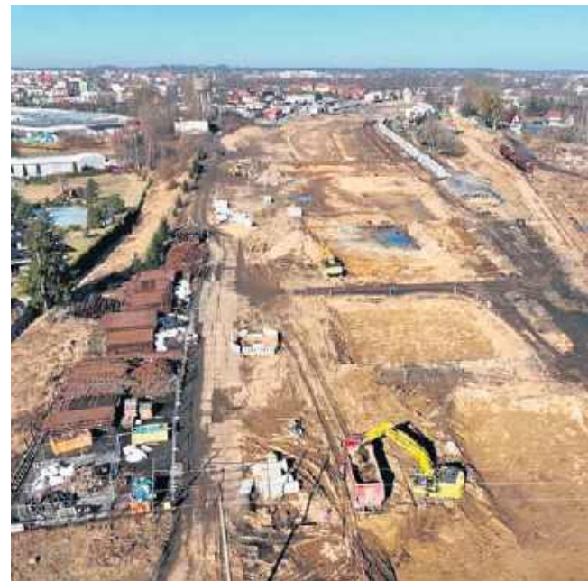
Efekty przebudowy widać już gołym okiem
