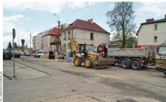
Prace przy budowie ronda idą pełną parą
