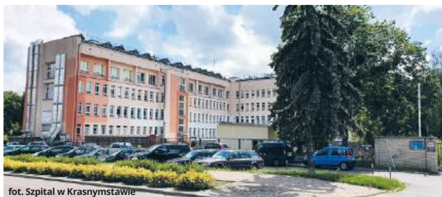
fot. Szpital w Krasnymstawie
