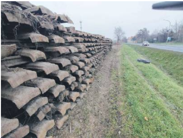
Prace na remontowanej linii są widoczne. Przy ul. Dzierżonowskiej w Strzelinie ustawione są pryzmy z kilkoma tysiącami zdemonstrowanych betonowych i stalowych podkładów oraz starymi szynami
