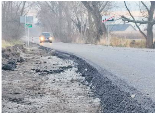
Na całym odcinku drogi położona jest już solidna warstwa asfaltu. W sobotę brakowało jeszcze tylko utwardzenia poboczy w niektórych miejscach
