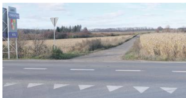
Droga, prowadząca na bocznice w Górcie Sobockiej
