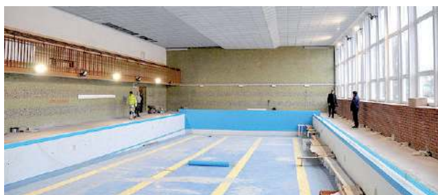
Koniec robót na basenie przy Szkolnej przewidywany jest w marcu przyszłego roku, oddanie pływalni do użytku - na w kwietniu
