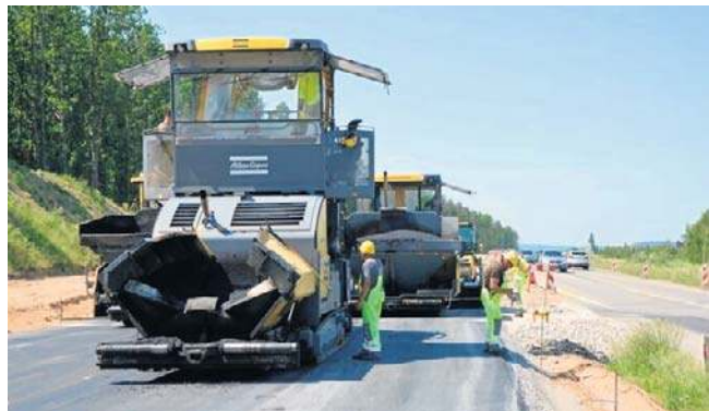
Budowa trasy ekspresowej S6 na zachód od Lęborka
