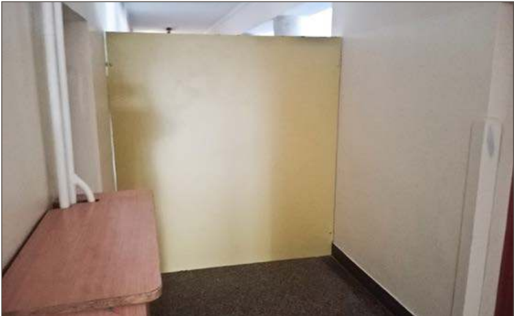
Dostęp do wyremontowanych pokoi na parterze jest niemożliwy.
