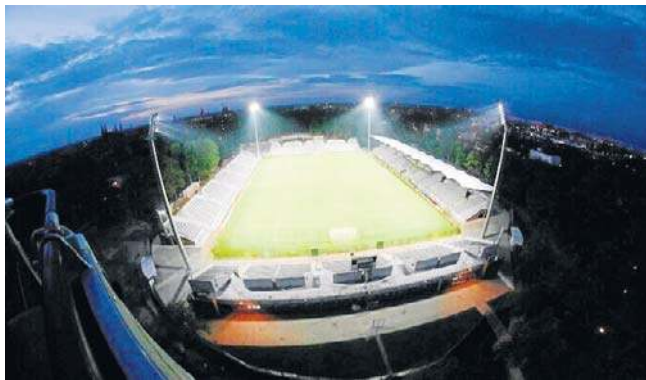
Dzięki modernizacji, powstało profesjonalne oświetlenie
