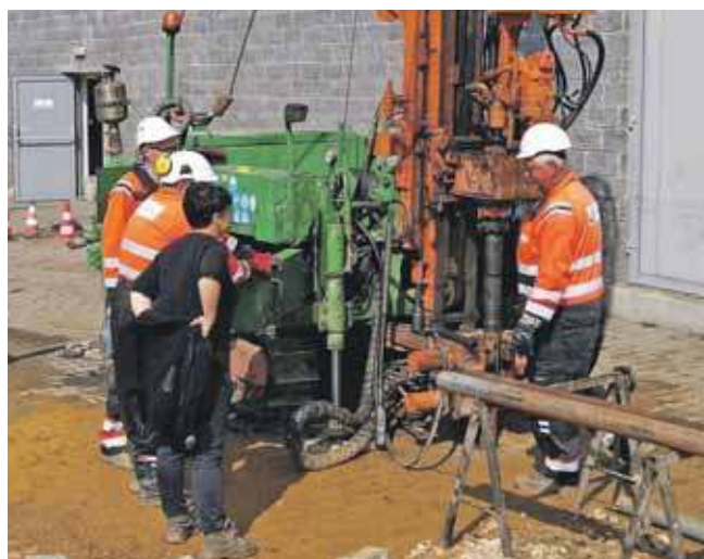
We wrześniu, kilka dni po pojawieniu się zapadliska, wykonano trzy odwierty
