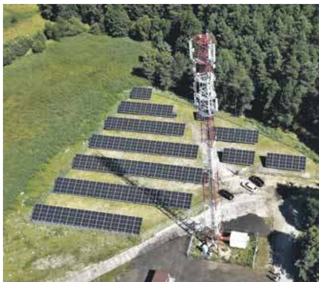
Kalety doceniono m.in. za budowę farmy fotowoltaicznej przy Miejskiej Oczyszczalni Ścieków
