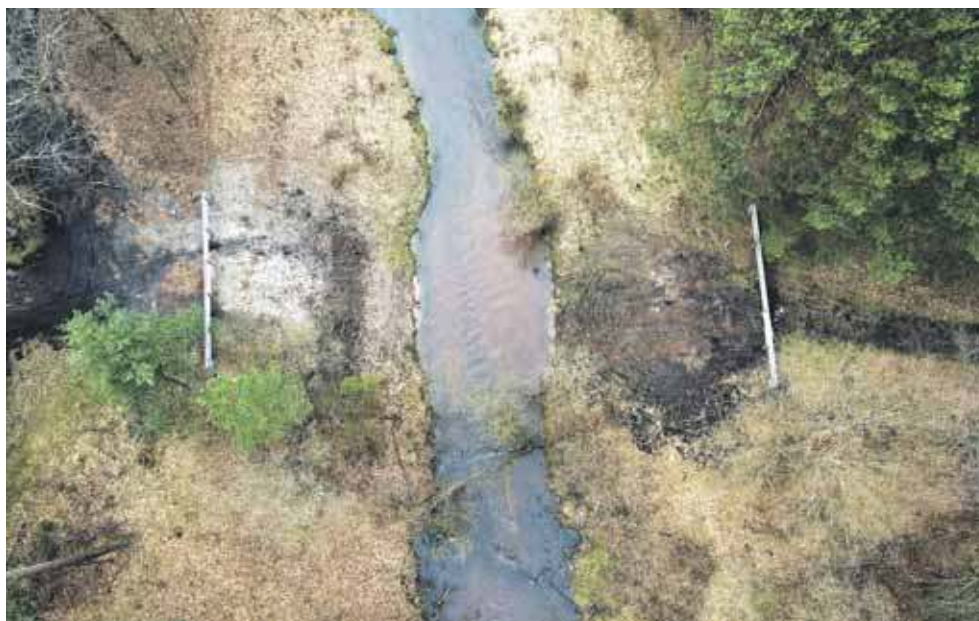
W miejscu spalonego mostu ma zostać wybudowana kładka dla pieszych i rowerzystów. Póki co przeprawy w tym miejscu nie ma
