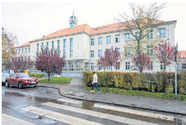
Wykonawca inwestycji zakończył już prace dekarские nad głównym budynkiem i laboratorium
