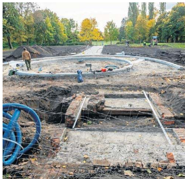
W tym miejscu w Parku Ludowym im. Wincentego Witosa odkryto kryptę nagrobną
