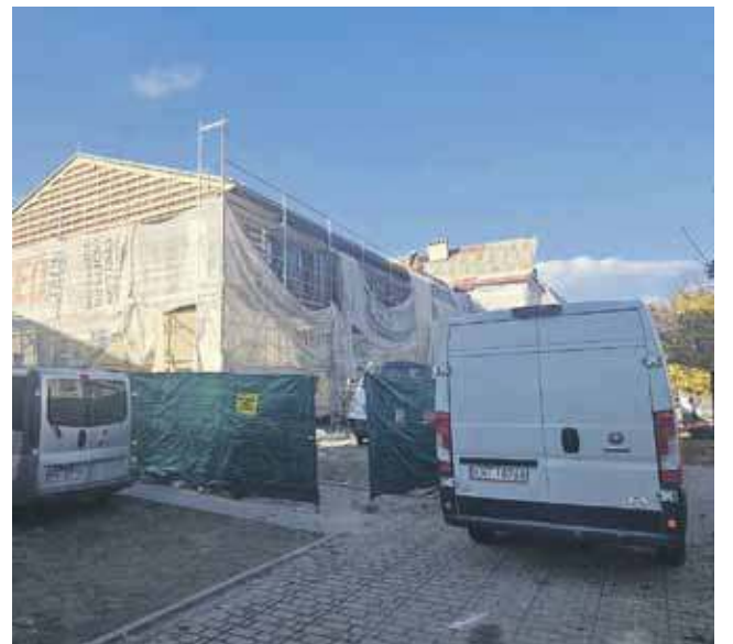
Trwa remont budynku przy ul. Jana Kazimierza, do którego w przyszłym roku przeniesie się częściowo PCPR.
